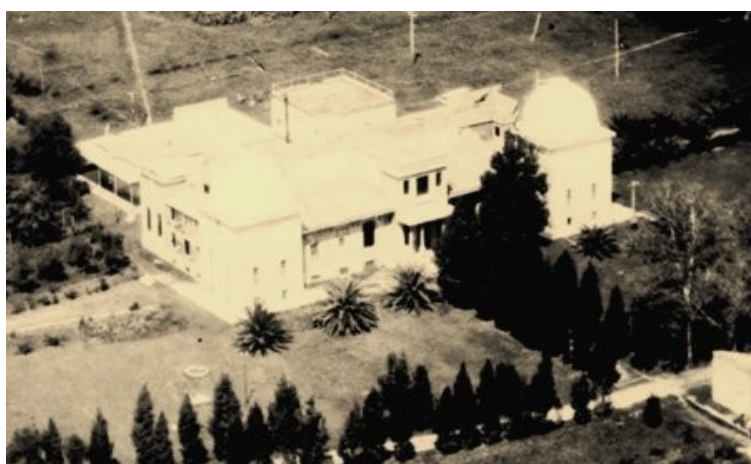
El edificio del Observatorio de Córdoba con la parte vieja ya reemplazada.
