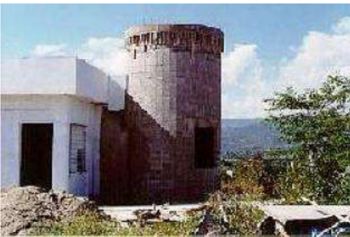
Detalle de la cúpula en construcción - Miguel Rojas - Web
