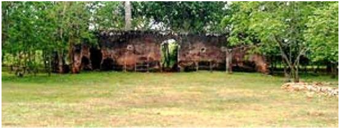
Restos de unas instalaciones azucareras de la región - Web
