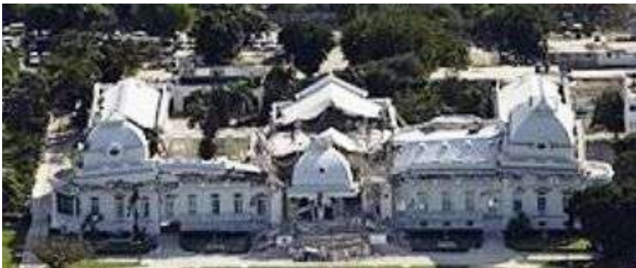
Derrumbe del Palacio Nacional de Haití por el terremoto del 12 - 01 - 2010 .
